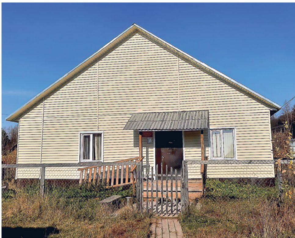
Новый современный ФАП закрыт, потому что в нём некому работать
