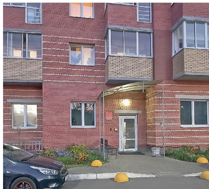
Вход в подъезд без ступенек – любая коляска проедет
